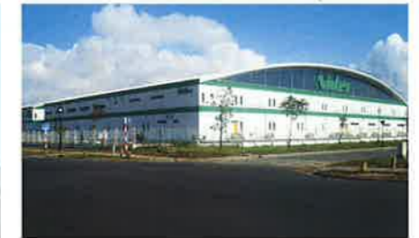
ベトナム日本電産会社 技術開発センター Nidec Vietnam Corporation Technical Center
