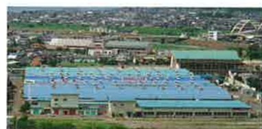
小浜技術開発センター(生産部) Obama Technical Center (Manufacturing)
